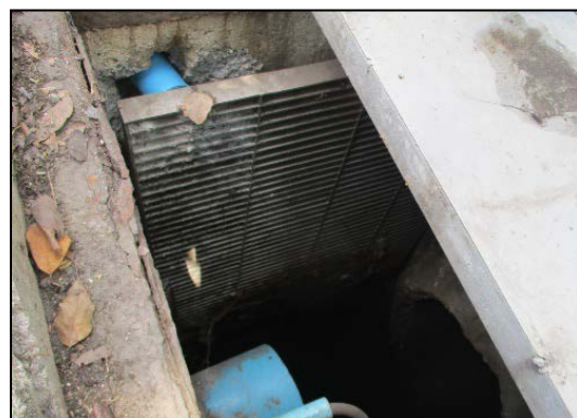
รูปที่ 1-6 จุกระบายน้ำลงสู่ท่อสาธารณะริมถนนสาทรใต้
